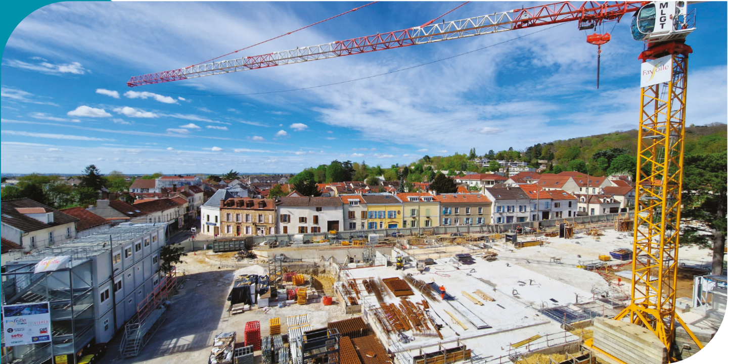
Travaux du nouveau Cœur de Ville - En cours
