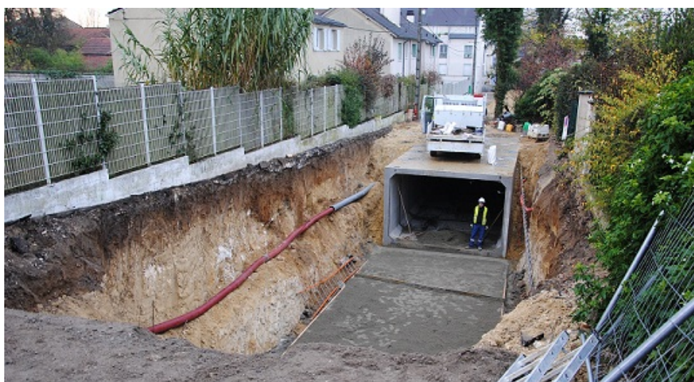
Chantier du bassin de retenue des Jollies (2010)
